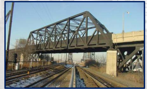
Thru-Truss (Span 44)
